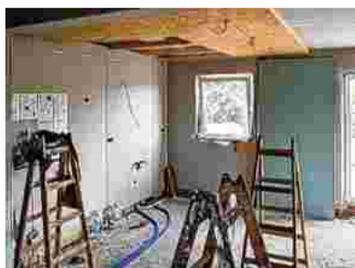
Innen wird noch eifrig gearbeitet.
