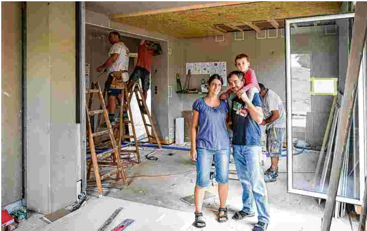
Im Haus von Markus Rabeder und Martina Steinhäusler wird fleißig gearbeitet und regelmäßig gelüftet.
