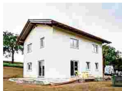
Das Haus in Pfarrkirchen
